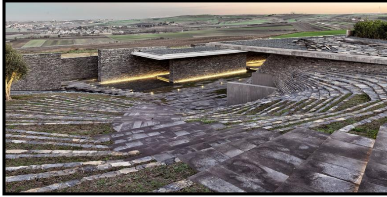
Görsel 12. Sancaklar Cami İç Mekan Gün Işığı Alınması
