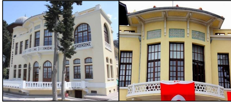
Görsel 1. Devlet Tiyatrosu binası genel görünüm ve pencere alınlıkları çini panoları (Merve Aktan Arşivi 2024: Mart).
